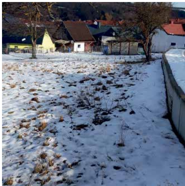
Auf dem Grundstück, Stützmauer östliche Grundstücksgrenze zur Zufahrt Kindertagesstätte „Regenbogen“ Geraberg
