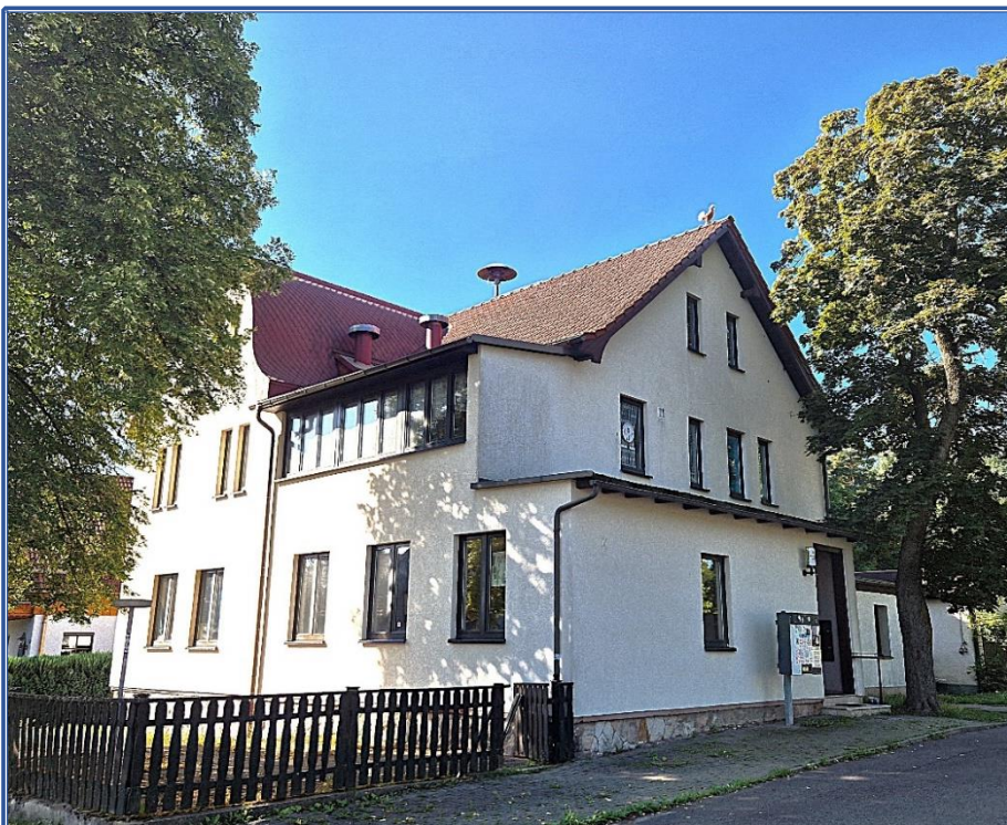
Straßenfront mit rechter Gebäudeseite
