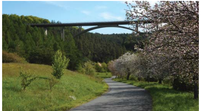
Geschwenda, Wirrbachtalbrücke, B 88
