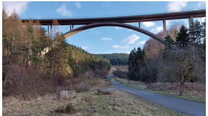
Geschwenda, Wirrbachtalbrücke, B 88
