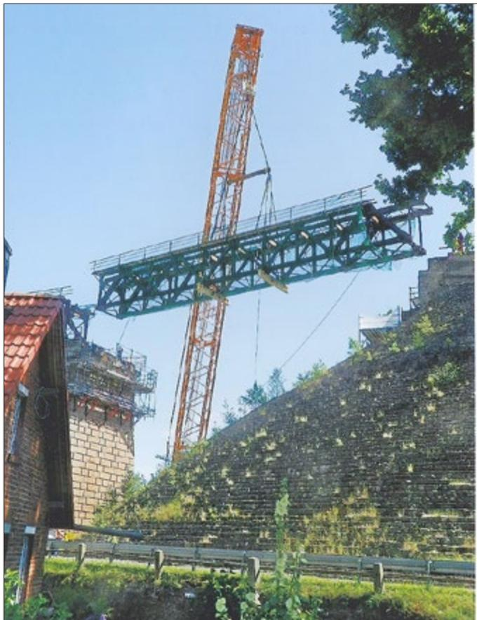
Gesichert durch Netze schwebt das erste, abgetrennte Brückensegment auf den Tiefclader.
