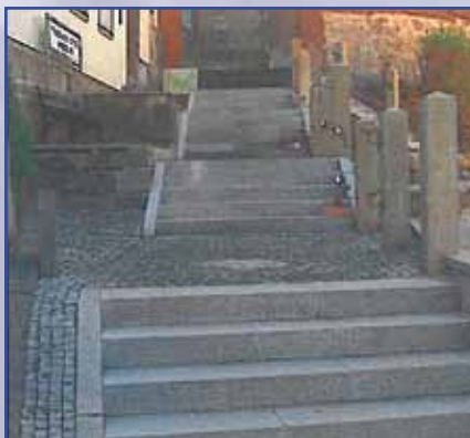
Die Treppenanlage wurde erneuert
