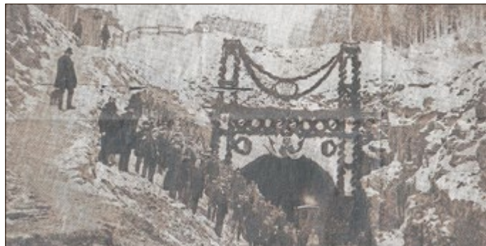
Das geschmückte Tunnelportal anlässlich des Durchstoßes am 21. Februar 1883 mit den geladenen Gästen.
