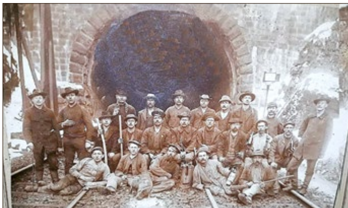
Immer wieder waren Reparaturarbeiten im Tunnel nötig. Diese Mannschaft stellt sich um 1910 dem Fotografen.
