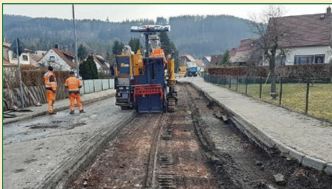
Erneuerung Geraer Straße, OT Geraberg Fräsarbeiten; Fa. STRABAG AG
