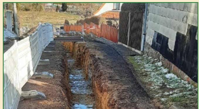
Decksanierung Wiesenstraße, OT Frankenhain Herstellung Mediengraben für Gas, Elektro, DSL und Straßenbeleuchtung; Fa. STRABAG AG
