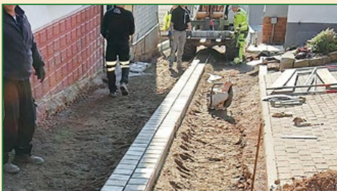
Ausbau Borngasse, OT Geschwenda Herstellung der mittigen Entwässerungsrinne; Fa. Tiefbau Gotha GmbH
