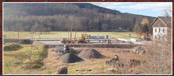
Dank des milden Winters konnten hier die Arbeiten ohne Unterbrechung fortgeführt werden. So konnte der Kanalbau mit Vorverlegung des Schmutzwasserkanals in Richtung Dörrberg fertig gestellt werden und mit dem Straßenbau sowie dem Wetterschutzhäuschen begonnen werden. Die Baufirma arbeitet unter Hochdruck daran den Endtermin Anfang/Mitte Juni zu halten.
