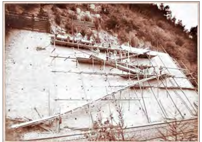
Tunnelarbeiten „Am Zwang“
