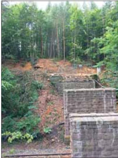
Wir, der Heimatverein Gräfenroda e.V., der CDU Ortsverband Gräfenroda und engagierte Bürger, wollen ehrenamtlich die so beliebte Wanderwegverbindung instand setzen und teilweise erneuern. Dazu sind die Abrissarbeiten der „alten Brücke“ bereits erledigt und derzeit wird an der Sanierung der Pfeiler und Widerlager gearbeitet.
